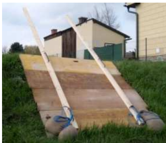
Diese Plattenkonstruktion könnte auf der Wasserseite des Dammes eingebracht werden, um eine Schadstelle abzudichten
