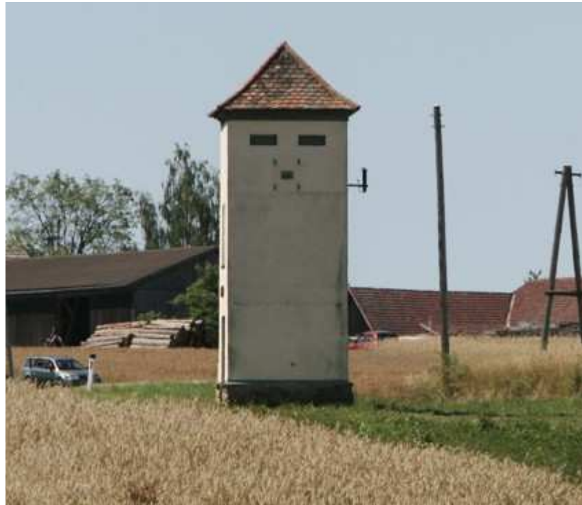
Das letzte Bild vom Transformator
