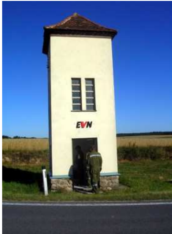
Der ausgediente Trafo der EVN diente als Übungsobjekt und wurde von der Sprenggruppe 22
