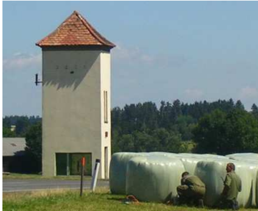
LM Bayreder bereitet die Sprengung vor
