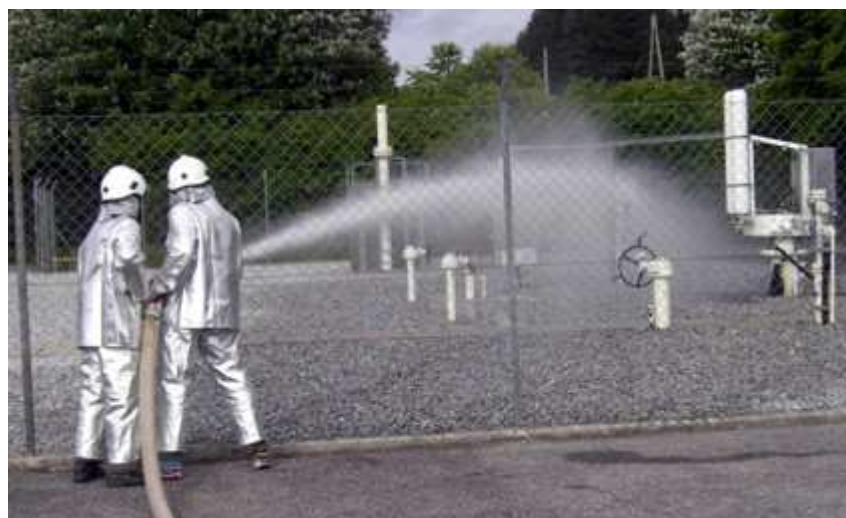
Die Gasaustrittsstelle bei einem Manometer wird mit B-Rohr und Stützkrümmer gekühlt und damit vor Entzündung geschützt
