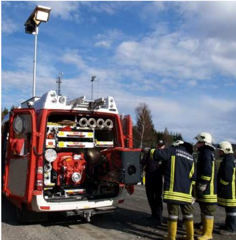
4: Elektrische Ausrüstung: Die Inbetriebnahme von Stromerzeuger und Lichtmast ist ein wesentlicher Punkt eines Einsatzmaschinenisten.
