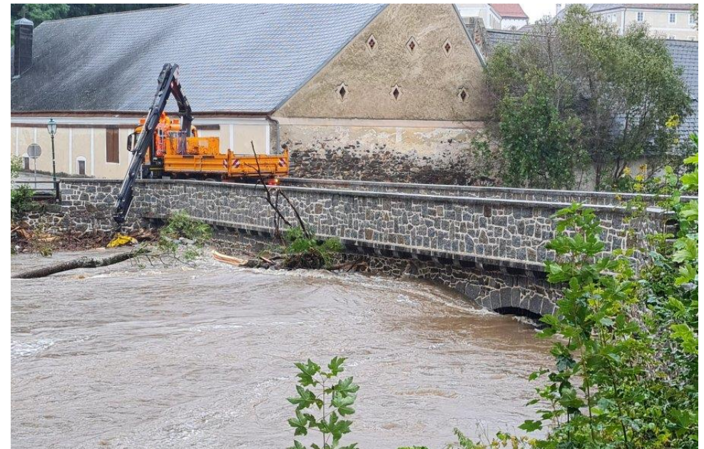
Ein LKW der Straßenmeisterei Zwettl beseitigt die Verklausungen bei der gesperrten Kampbrücke in Stift Zwettl.
